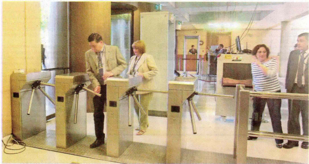
La tecnología y el control restringido son parte integral de los sistemas de acceso y seguridad modernos.
