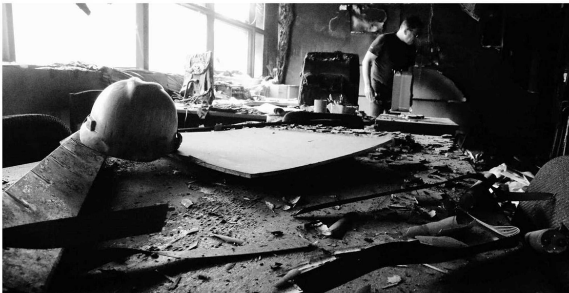
Los daños a la infraestructura pública y privada han sido cuantiosos. Por eso expertos creen que se registrará una activación en esta área.
